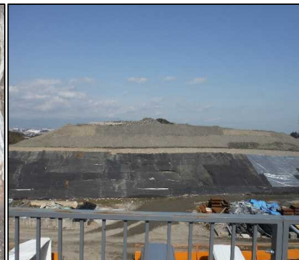
④ 選別土仮置・盛土工
