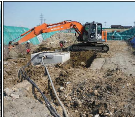
③ 廃棄物土掘削工
