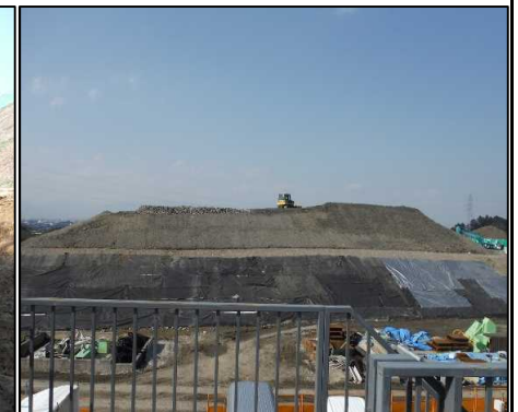
④ 選別土仮置・盛土工
