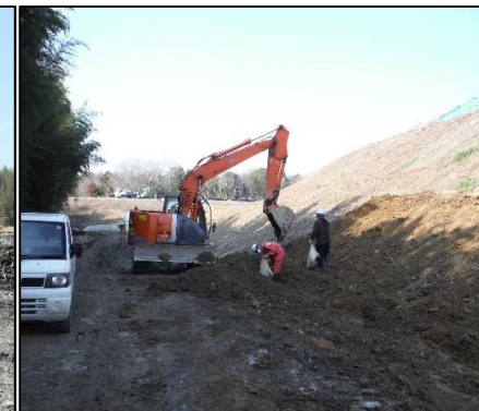
② 廃棄物土掘削工
