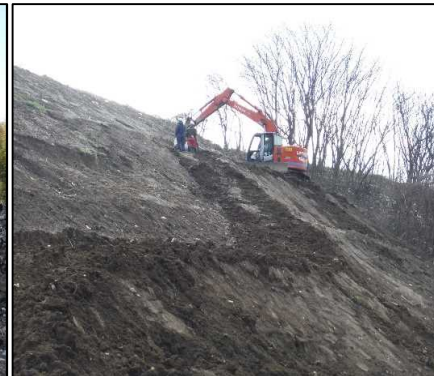
②-2 廃棄物土掘削工
