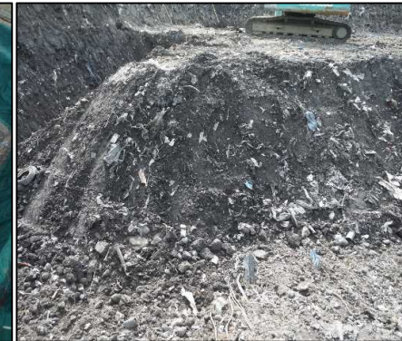
① 廃棄物土掘削工
