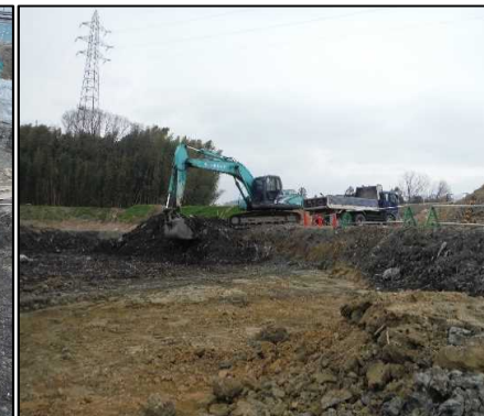
② 廃棄物土掘削工 A工区への進入路を確保するため廃棄物土を掘削しています。
