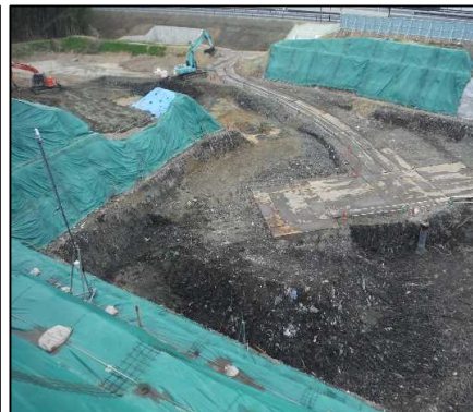
① 廃棄物土掘削工 A工区の掘削状況と運搬路です。
