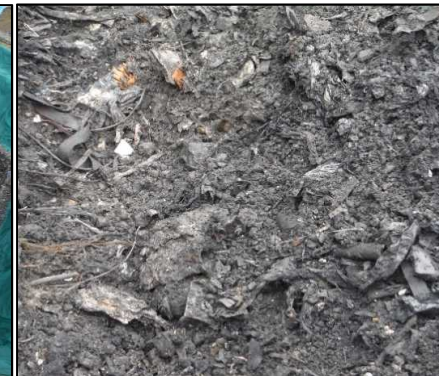
① 廃棄物土掘削工 A工区の廃棄物土の状況です。可燃物が多くなっています。
