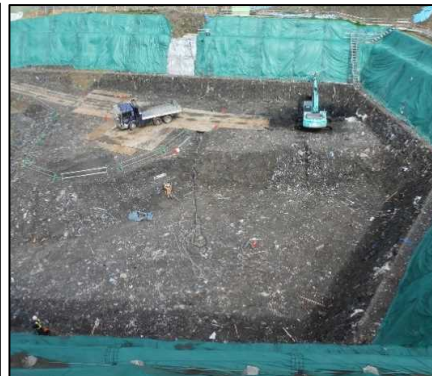
① 廃棄物土掘削工 A工区で廃棄物土を掘削しています。最深部でEL=128.0mです。(4月11日現在)
