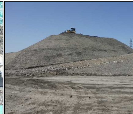
③ 選別土仮置・盛土工
