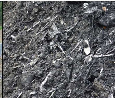
②-1 廃棄物土掘削工
