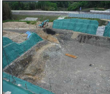
②-1 廃棄物土掘削工 A工区で従来のダンプ進入路を掘削しています。この後、新しい進入路に鉄板を敷きます。
