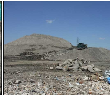
④ 選別土仮置・盛土工
