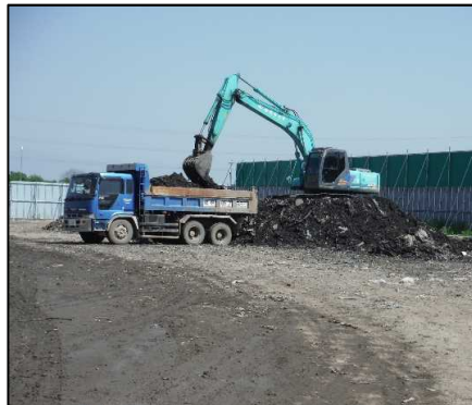
①-2 廃棄物土掘削工
