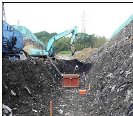
①-1 廃棄物土掘削工
