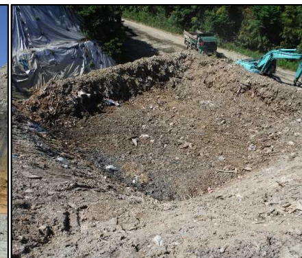
②-2 廃棄物土掘削工
