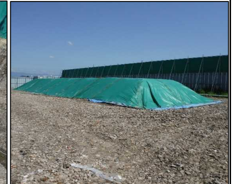
④-3 選別土仮置・盛土工
