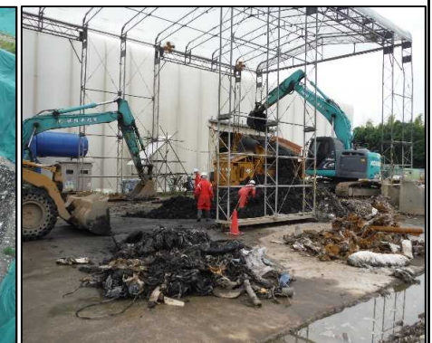
⑤ 選別処理工 自走式スクリーン+重機+人力にて粗選別を行っています。
