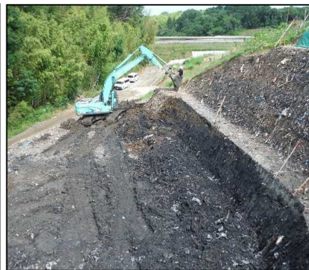
②-2 廃棄物土掘削工 C工区廃棄物土を掘削しています。
