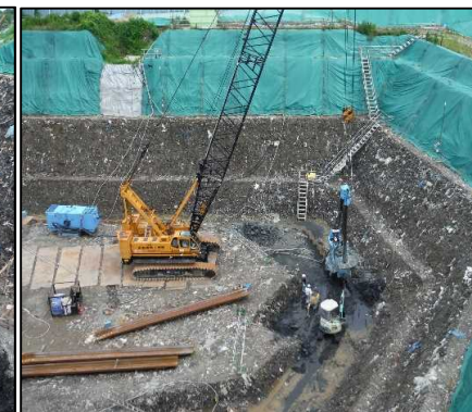
③ 矢板工 A工区にて止水矢板の圧入を行っています。
