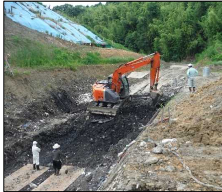
①-3 廃棄物土掘削工
