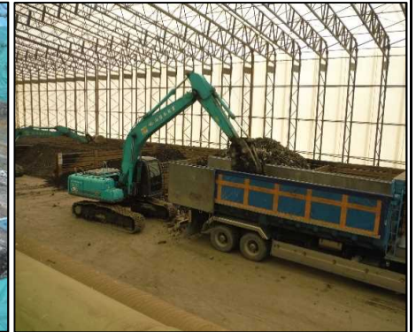
④ 選別処理工
