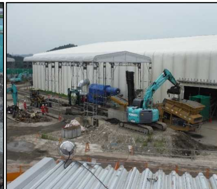
④ 選別処理工
