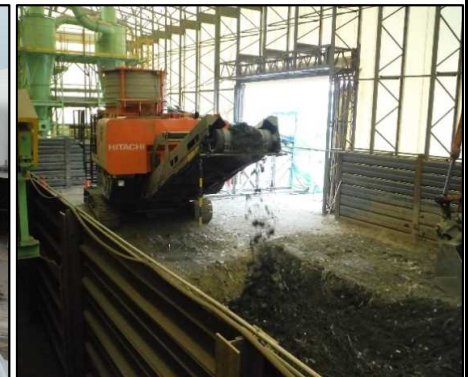
④ 選別処理工
