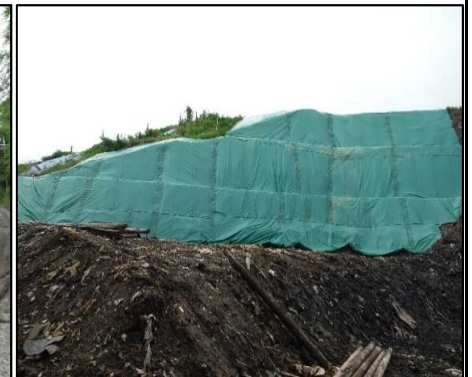
①-4 C工区掘削 掘削が完了した法面はシートでキャッピングをしています。
