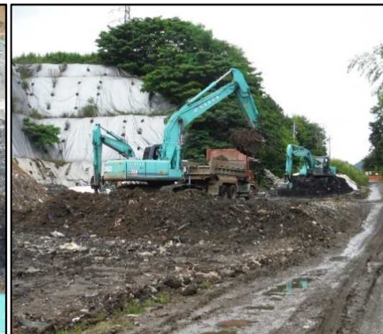
①-2 廃棄物土乾燥 廃棄物土を乾燥させるために仮置きしています。(写真右奥) 乾燥させた廃棄物土を選別施設へ運搬しています。(写真中央)
