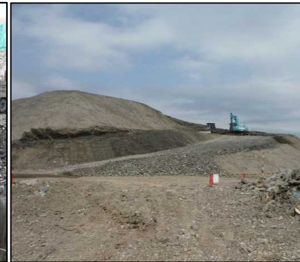
② 選別土仮置・盛土工
