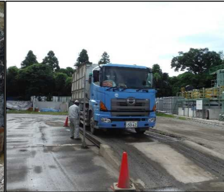
③ 選別処理工 トラックスケールにて重量を計測し過積載にならないようにしています。
