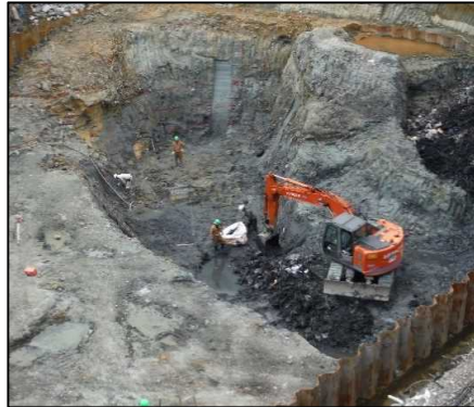
①-1 A工区掘削 止水矢板の内側を掘削しています。
