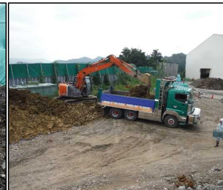
覆土の搬出 分析の結果、埋戻しに不適合な土を場外へ搬出しています。
