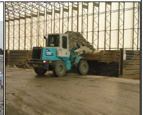
③ 選別処理工 選別が終わった50mmアンダー選別土を保管ヤードに仮置きしています。
