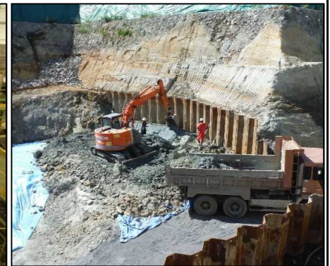
④ 底面・側面遮水工
