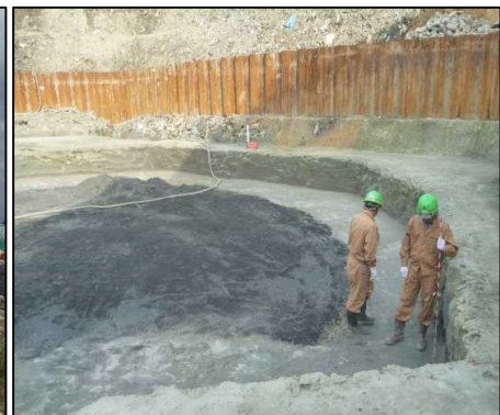
④ 底面・側面遮水工
