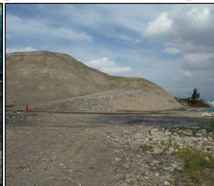
② 選別土仮置・盛土工
