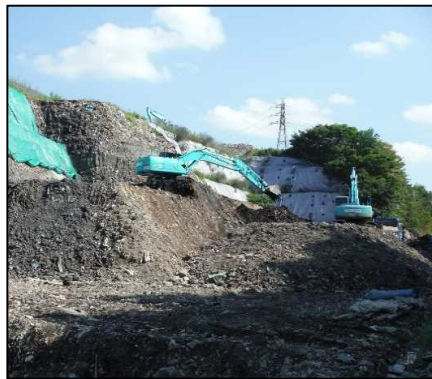
①-2 廃棄物土乾燥 掘削した廃棄物土を乾燥させています。
