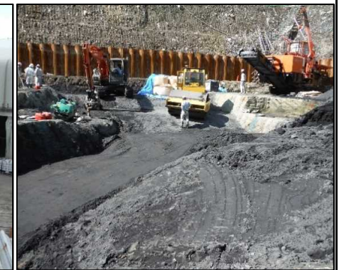
④ 底面・側面遮水工 基盤面の敷均し、転圧を行っています。
