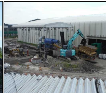
③ 選別処理工 自走式スクリーン、重機、人力にて粗選別(120mm以上のアス・コン、廃棄物を選別)しています。
