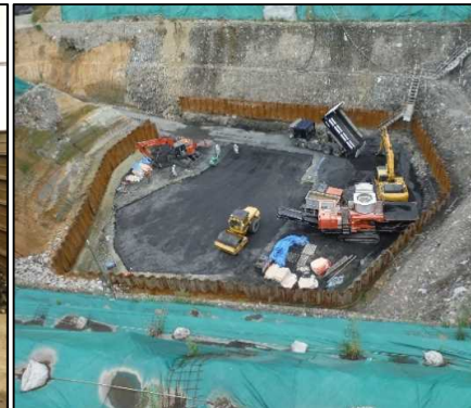
④ 底面・側面遮水工
