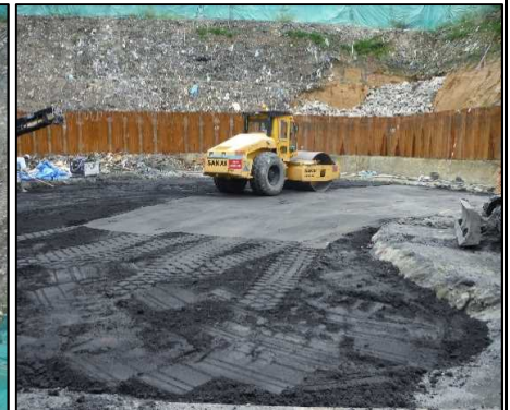
④ 底面・側面遮水工
