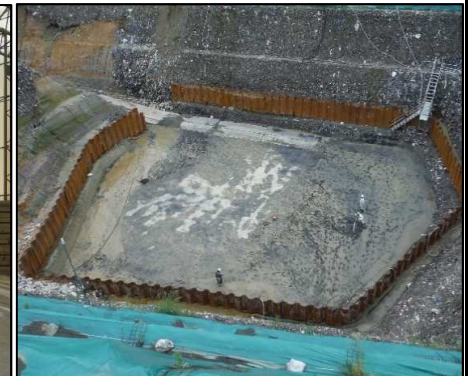
④ 底面・側面遮水工
