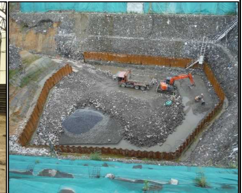
④ 底面・側面遮水工
