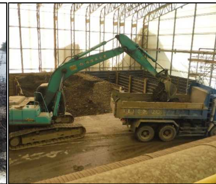
③ 選別処理工 適合試験によって基準値を満足した選別土を運搬するためにダンプトラックに積み込んでいます。
