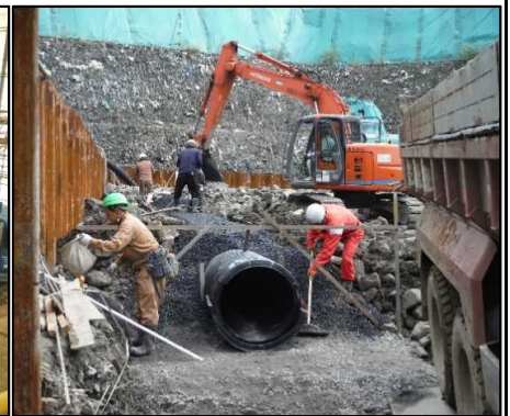
④ 底面排水工 排水管の周辺に、裏込め材(単粒砕石)を設置し整形しています。
