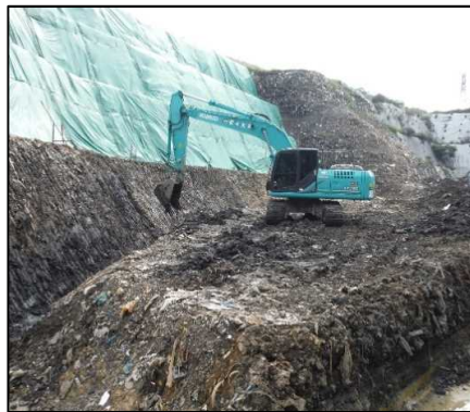
①-1 C工区掘削 廃棄物土を掘削しています。
