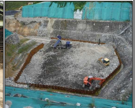
④ 底面・側面遮水工
