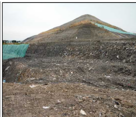
①-1 C・D工区掘削
