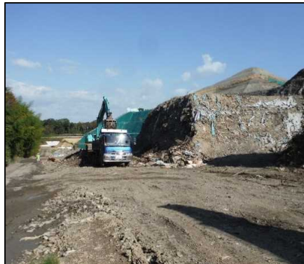
①-2 廃棄物土乾燥 C・D工区で掘削した廃棄物土を乾燥させた後、ダンプトラックで選別ヤードへ運搬しています。
