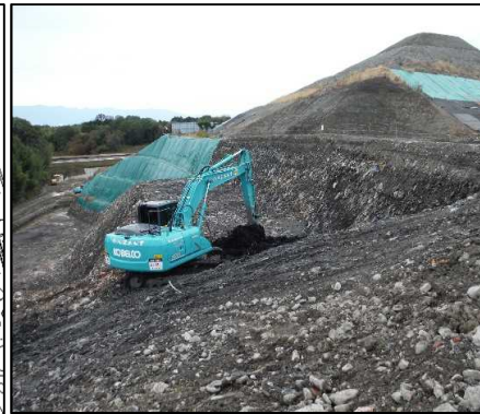
①-1 C・D工区掘削
