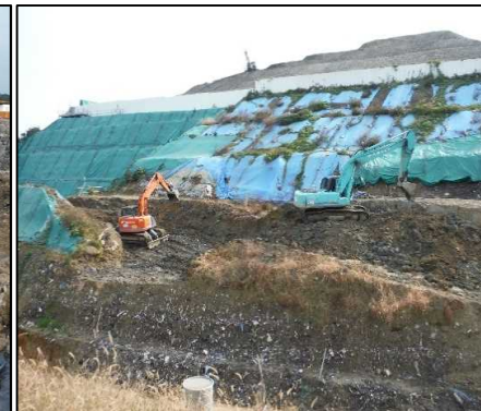
①-3 B工区掘削 B工区で掘削している様子です。
