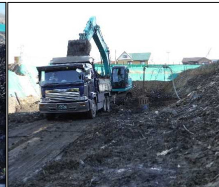
①-3 B工区掘削 B工区の廃棄物土を掘削しています。
