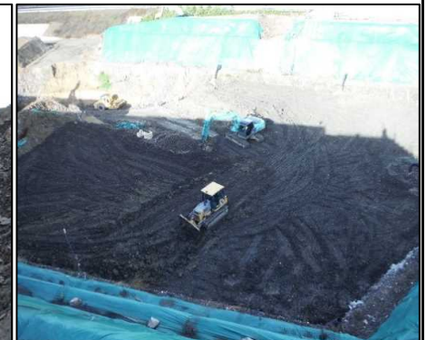
②-2 A工区埋戻し A工区の埋戻しを行っています。
