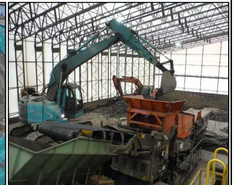
③ 選別処理工 スクリーンへ廃棄物土を投入しています。
