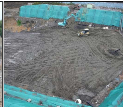
②-2 A工区埋戻し A工区の埋戻しを行っています。
