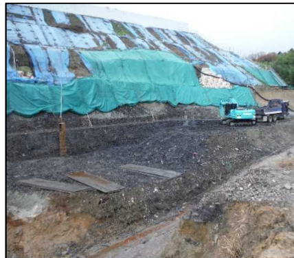
①-3 B工区掘削 B工区廃棄物土を掘削しています。
