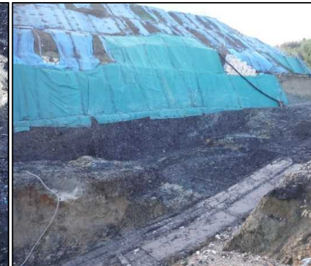
①-3 B工区掘削 B工区場内側の掘削現況です。
