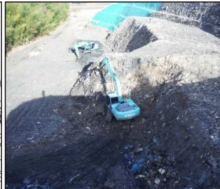
①-1 C・D工区掘削 C・D工区の廃棄物土を掘削しています。
