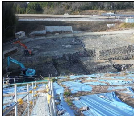
①-3 B工区掘削
