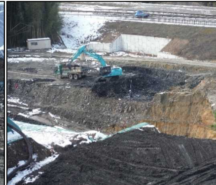
①-3 B工区掘削
