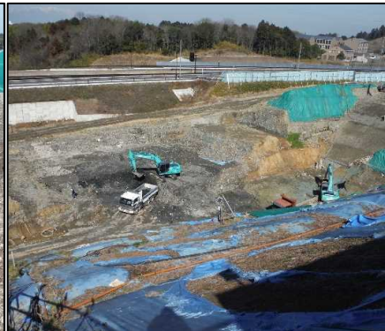
①-3 B工区掘削
