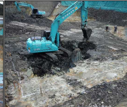
①-3 B工区掘削
