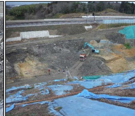
①-3 B工区掘削
