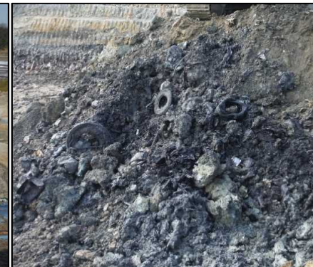
①-3 B工区掘削
