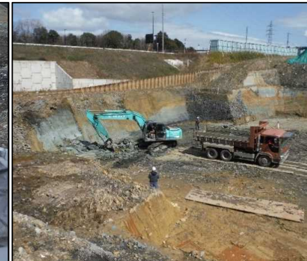
①-3 B工区掘削
