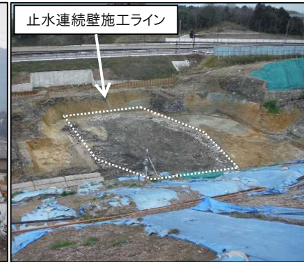
①-3 B工区掘削 B工区は標高EL=125mまで掘削が完了しました。4月から止水連続壁を実施します。
