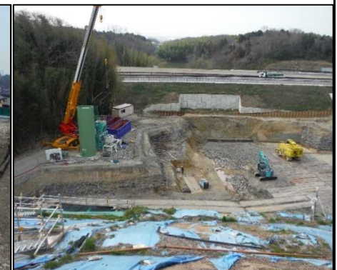
③ 止水連続壁工
