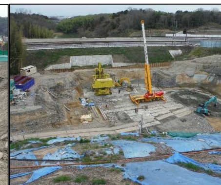
③ 止水連続壁工
