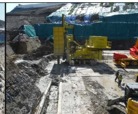
③ 止水連続壁工
