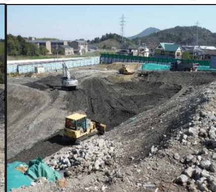
②-2 A工区仮置
