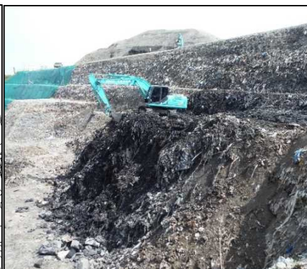
①-1 D・E工区掘削
