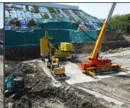
③ 止水連続壁工
