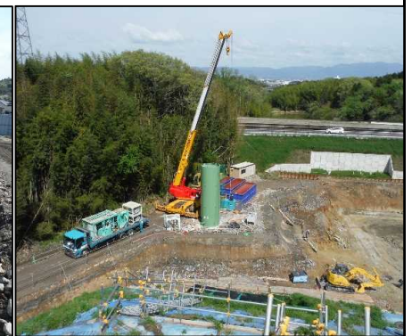
③ 止水連続壁工
