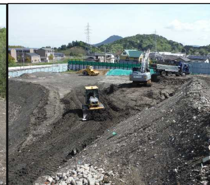
②-2 A工区仮置
