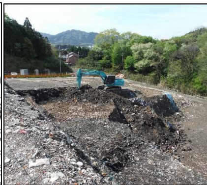
①-1 D・E工区掘削
